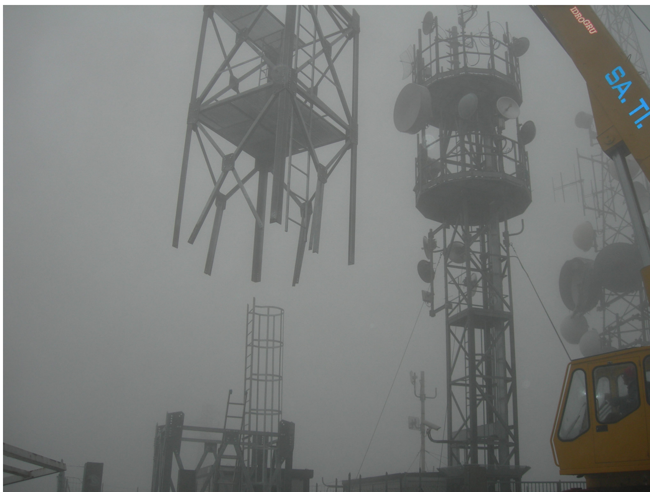
Fase di montaggio di un traliccio porta ANTENNE
