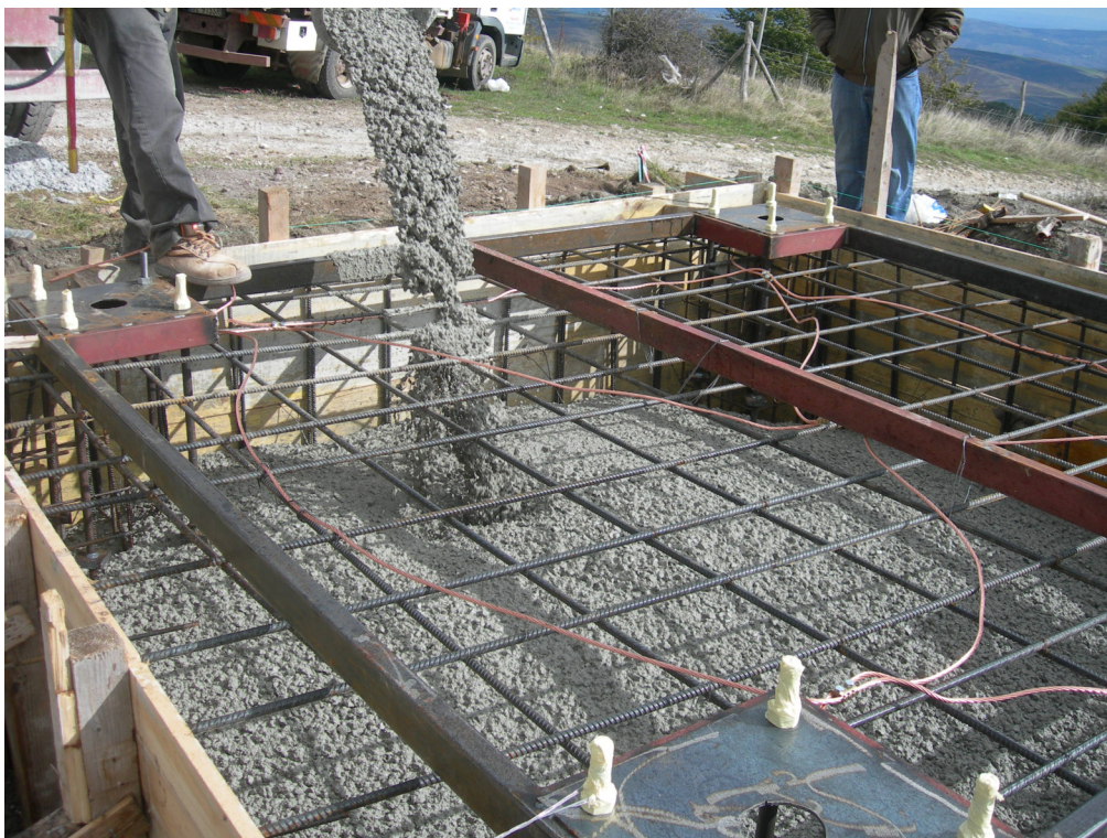
Fondazioni speciali per un traliccio porta ANTENNE
